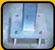
creare un punto di montaggio da cui l'ancoraggio verrà successivamente rimosso. Gli ancoraggi drop-in forniscono un incasso fisso per aste filettate,
